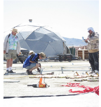
Dry Lake Bed Install
