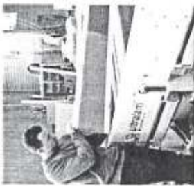
Vorfertigung von Wandelementen mit STEICOultralam R™ und STEICOultralam X™
